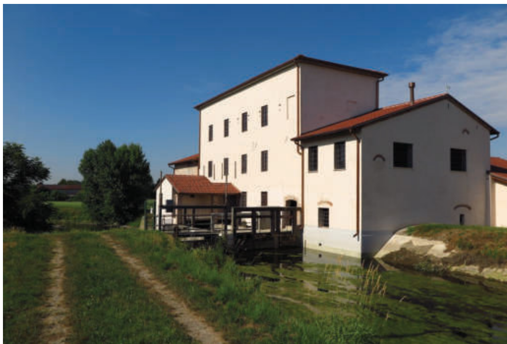
Molino di Torre Rossa. Sopra nel 2016, prima del restauro. Sotto nel 2017, dopo il restauro
