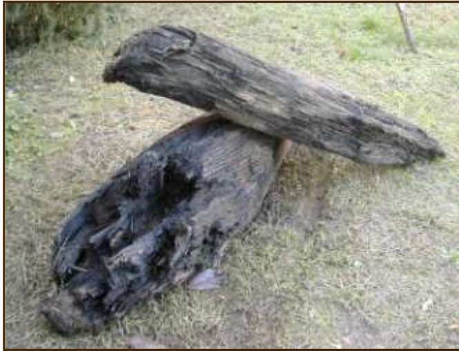
2003: Resti dei vecchi piloni del ponte di legno in via Ponte Napoleone a Camisano Vicentino.
