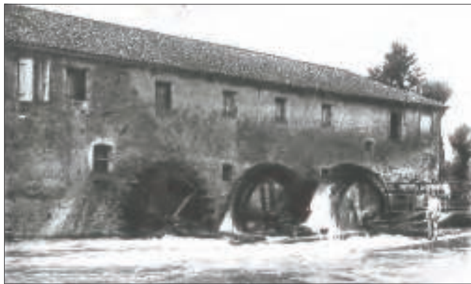
1915-1918. Il mulino prima dei lavori di sopra elevazione con le tre pale.
