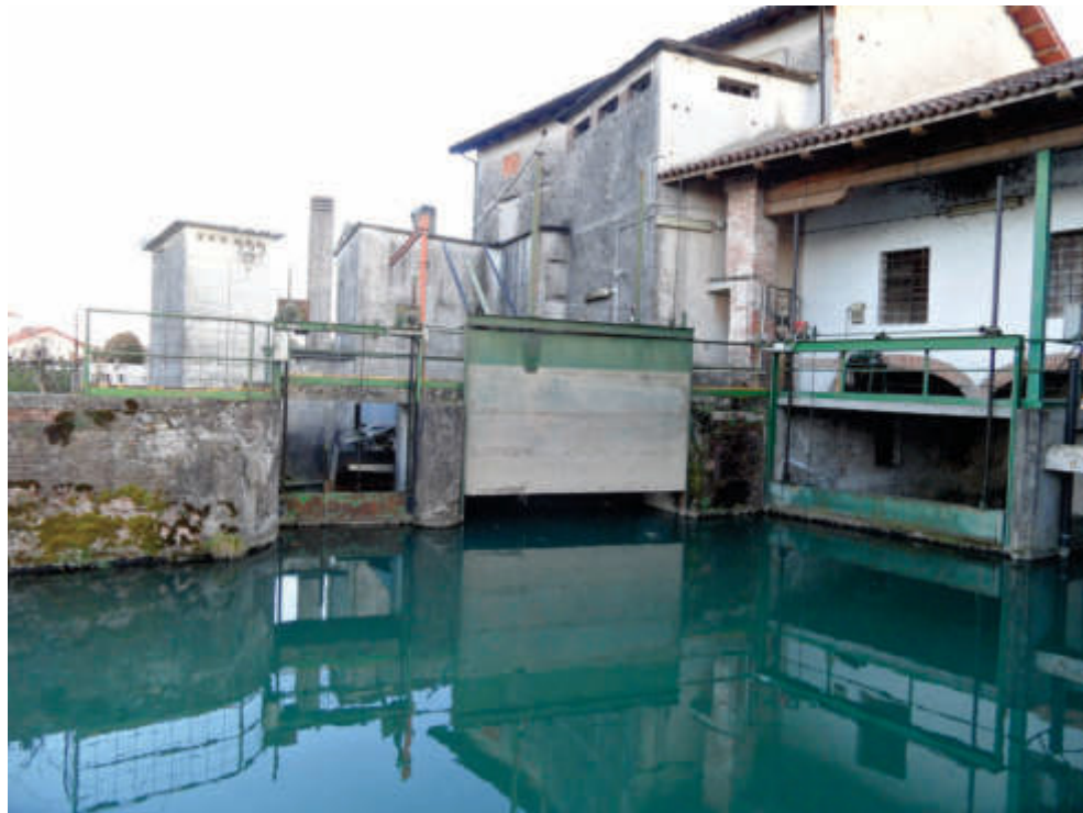
Foto 4 – Al centro la grande paratoia attraverso la quale l'acqua veniva convogliata nella seconda turbina installata nel 1928.
