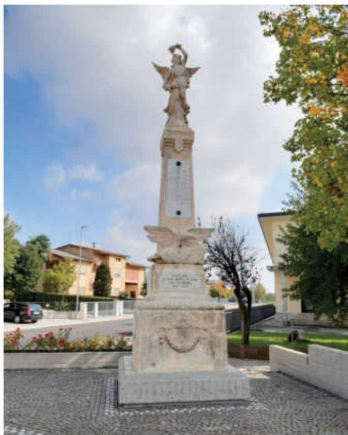
Bevadoro, Monumento ai Caduti – Stato del manufatto dopo l'intervento di recupero (foto Isabella Parin)
