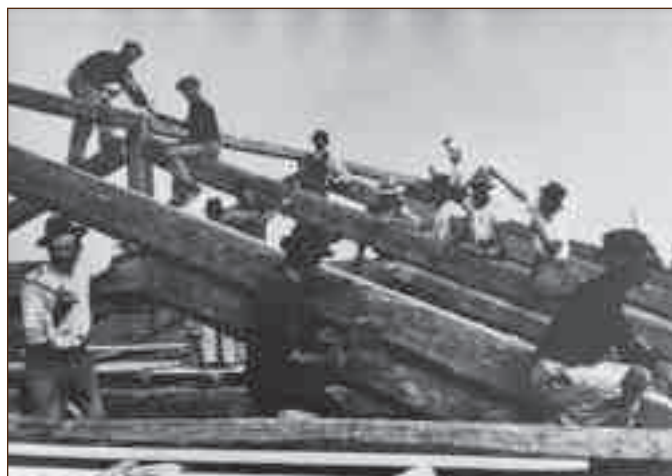
Camisano Vicentino 1938. Costruzione del Cinema LUX
