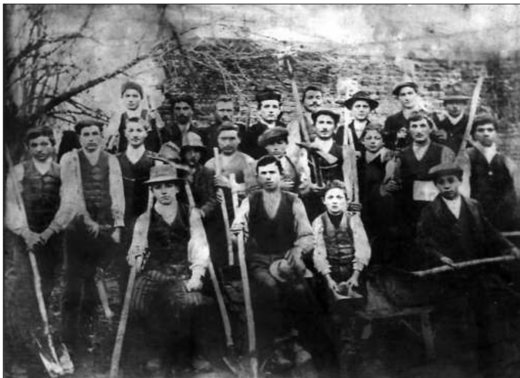
Camisano Vic. 1911. La squadra di muratori che costruirono il primo asilo parrocchiale a Camisano.
