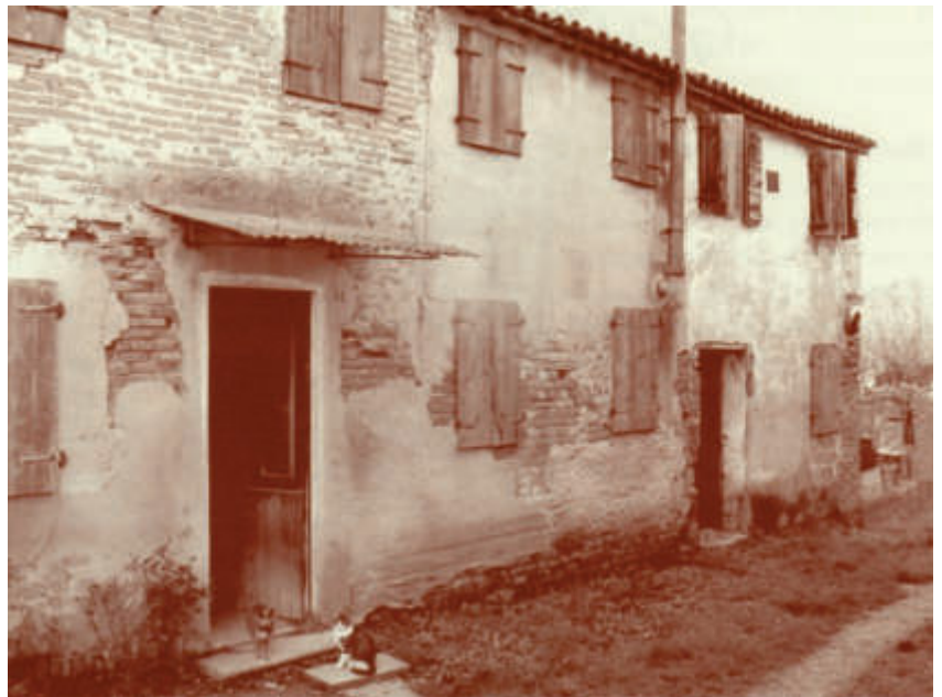
Visione laterale di Casa Negrin in Via S Daniele
